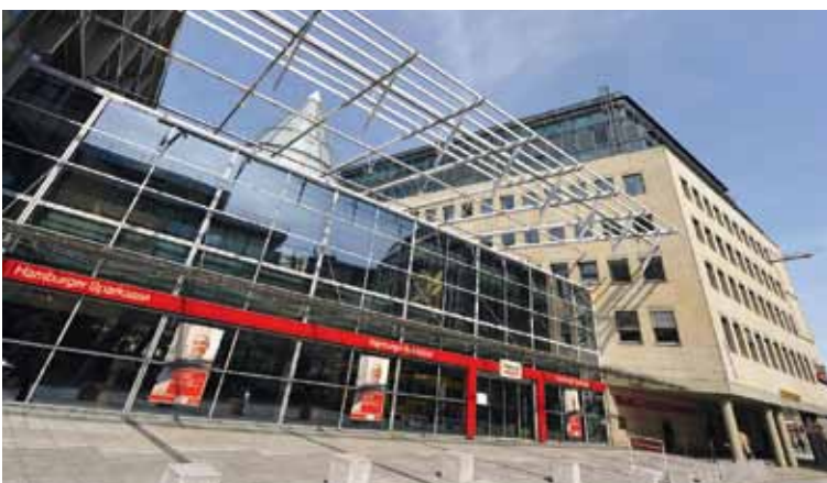
Haspa Zentrale Ecke Adolphsplatz/Großer Burstah
