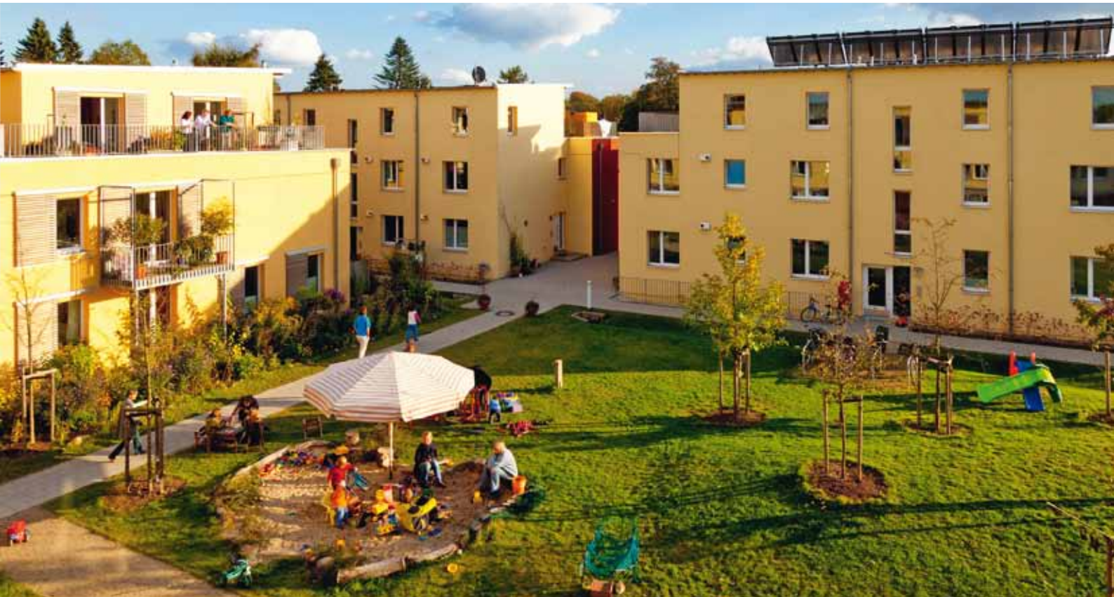
Klimaschutzsiedlung Klein Borstel
